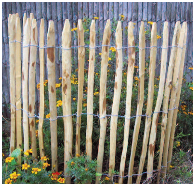
Fig. 3 - L'impiego di elementi in legno di castagno di sezione ridotta (sotto forma di paletti o segati), collegati tra loro tramite filo metallico, per realizzare piccoli recinti è piuttosto comune in Francia e nel Regno Unito.
